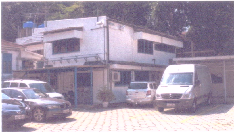
Edificações - Escritórios (Benfeitoria I)
