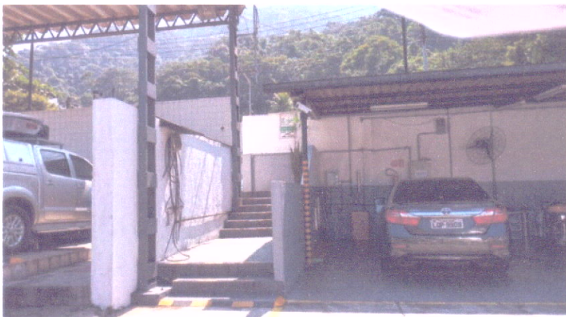
1º corte e talude existente no terreno
