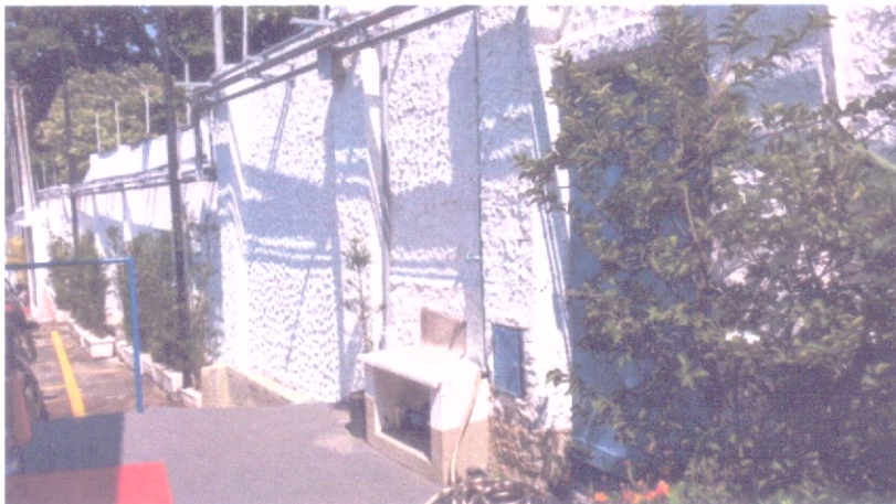
Testada Rua Br. de Oliveira Castro - tomada interna
