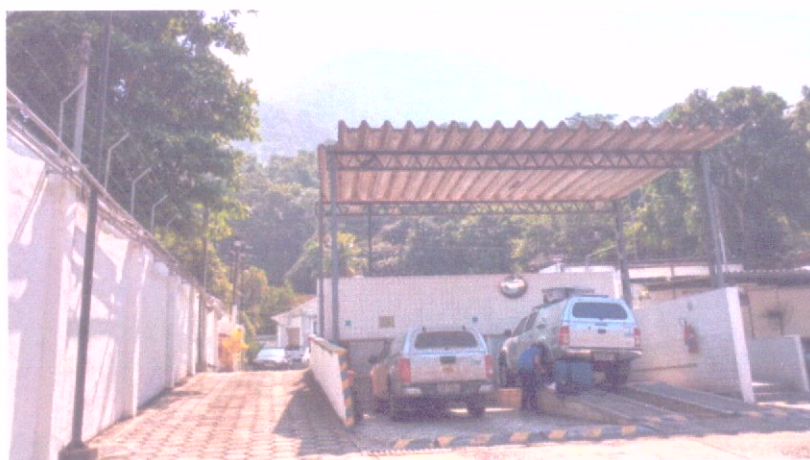
Edificações - Oficina (Benfeitoria III) e 1º corte com rampa existente
