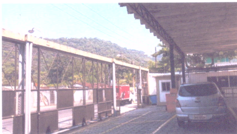
Testada para a Rua Pacheco Leão - tomada interna e cobertura de automóveis (Benfeitoria IV)
