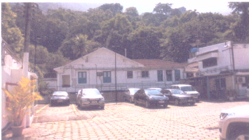
Aspectos gerais - 2º corte e talude existente
