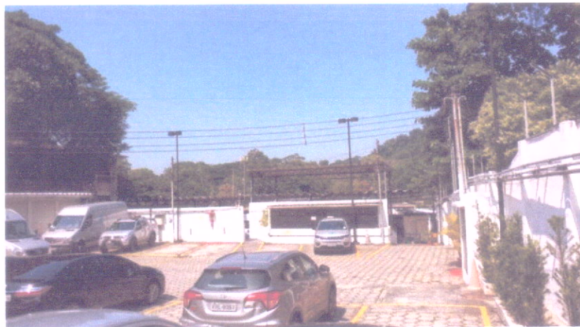
Aspectos gerais - Edificações oficina e lavagem de autos (Benfeitorias II e III)
