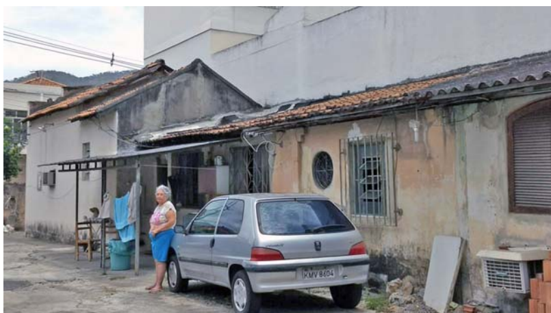
Fachada posterior edificação principal
