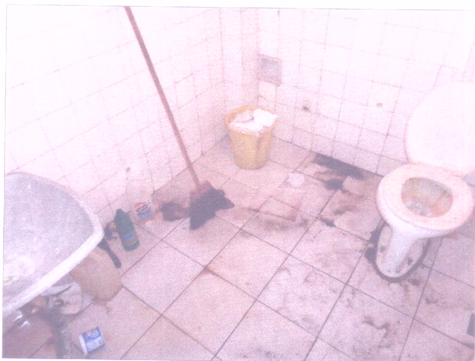
Figura 71 - Imóvel Avaliando (2º Pavimento).
