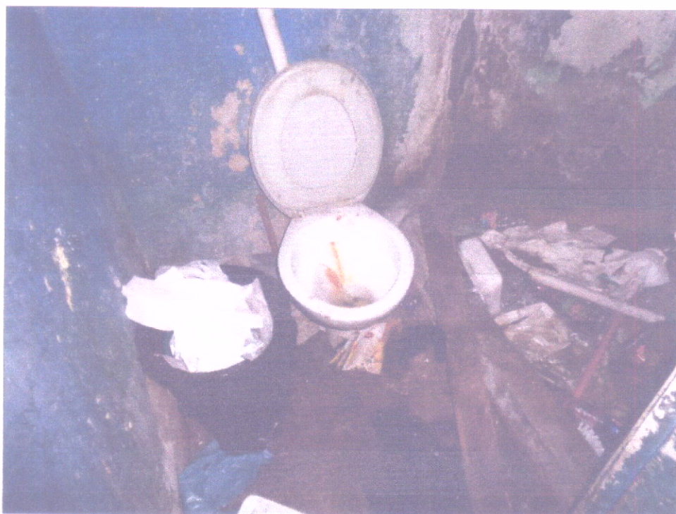
Figura 72 - Imóvel Avaliando (Térreo - 1º Pavimento).
