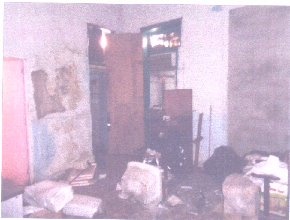
Figura 70 - Imóvel Avaliando (2º Pavimento).
