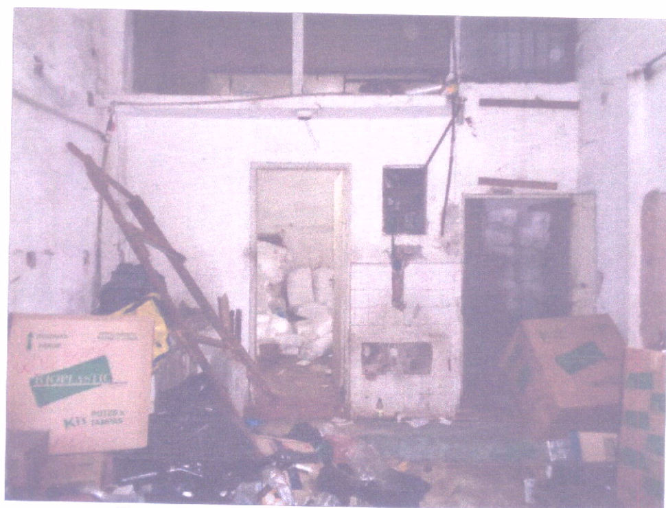
Figura 75 - Imóvel Avaliando (Térreo - 1º Pavimento).
