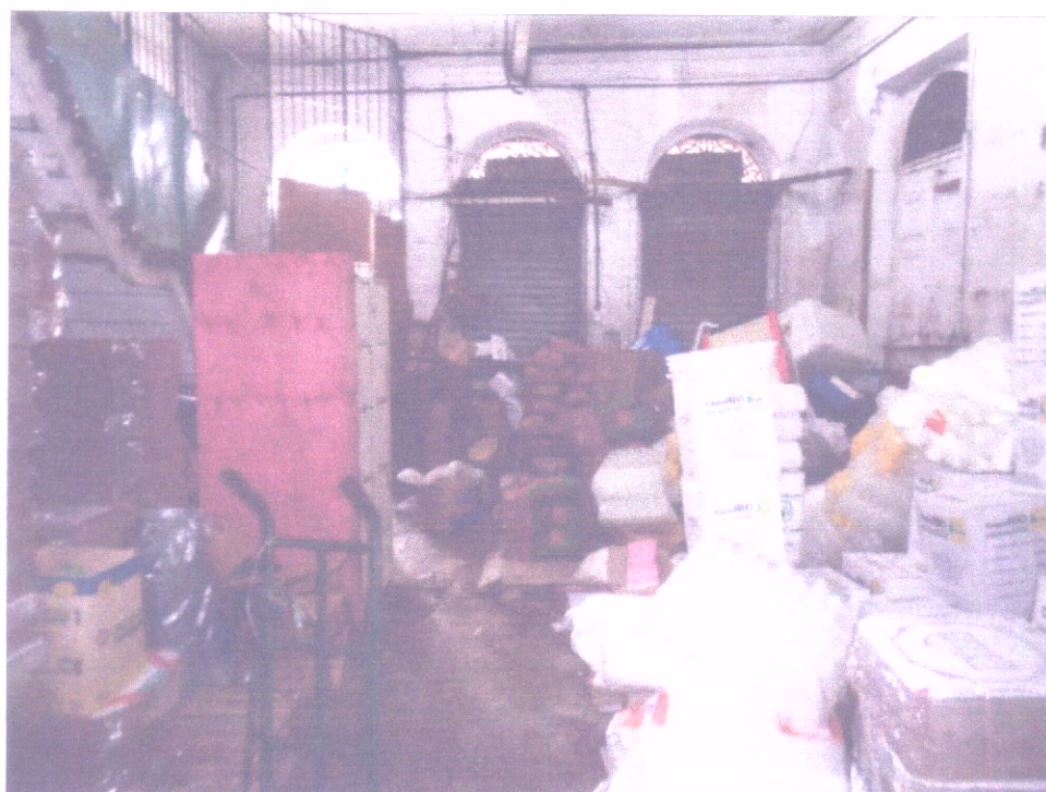
Figura 73 - Imóvel Avaliando (Térreo - 1º Pavimento).
