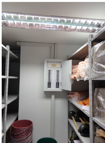
QUADRO DE DISTRIBUIÇÃO DE LUZ E TOMADAS 3 - ÁREA DE ARMAZENAGEM 1
