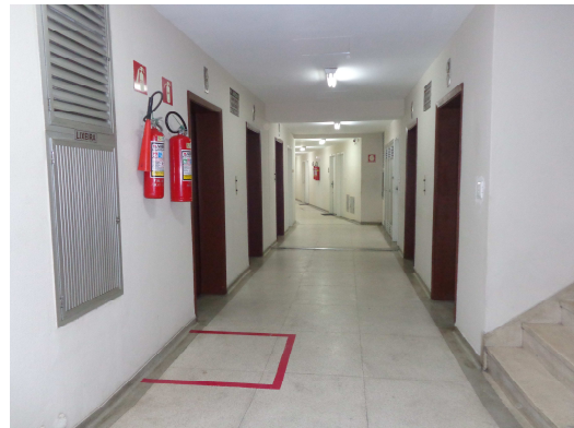
HALL DOS ELEVADORES
