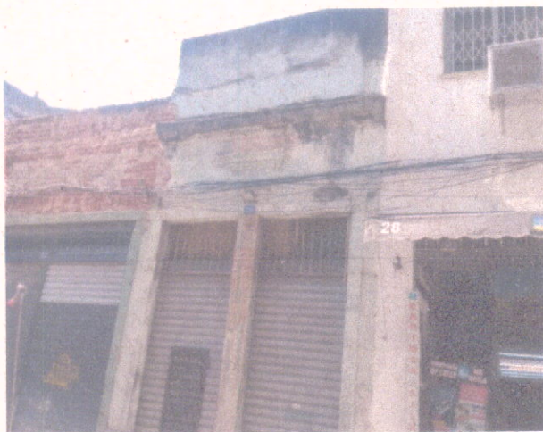
VISTA LATERAL DA FACHADA DO IMÓVEL
