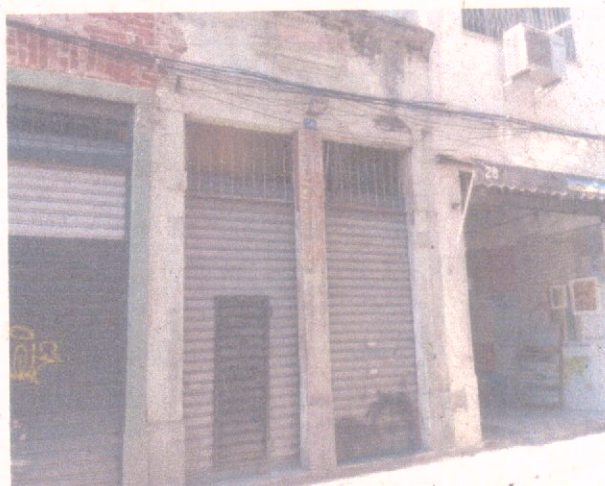
VISTA LATERAL DA FACHADA DO IMÓVEL
