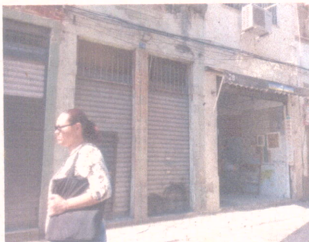
VISTA LATERAL DA FACHADA DO IMÓVEL
