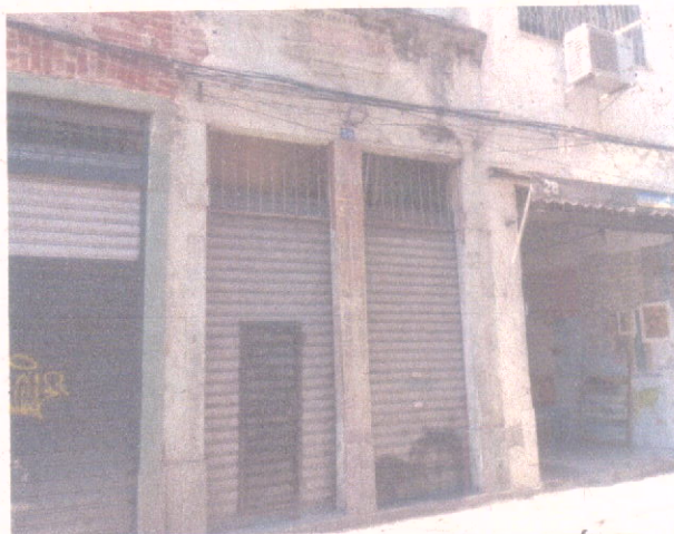
VISTA LATERAL DA FACHADA DO IMÓVEL
