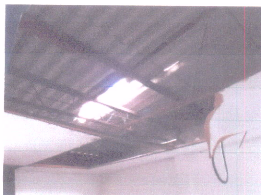
Sala sem parte do forro e telha da cobertura
