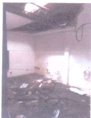
Sala sem parte do forro e telha da cobertura
