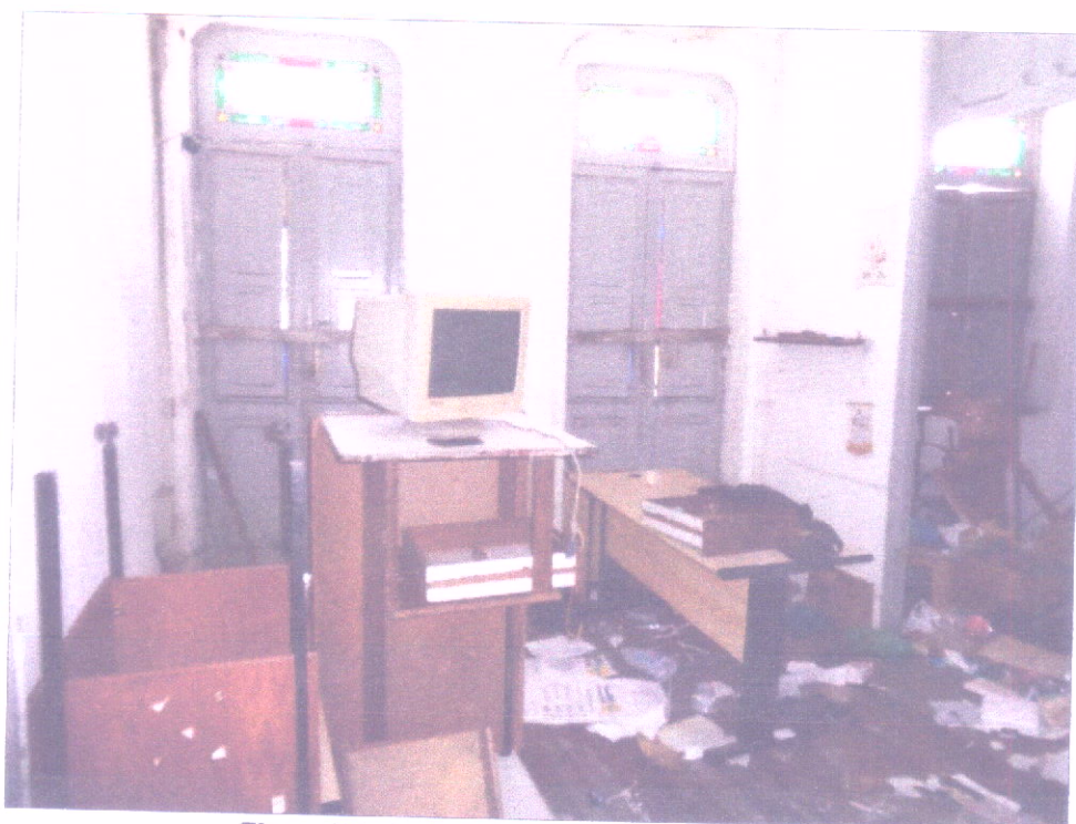
Figura 68 - Imóvel Avaliando (2º Pavimento).
