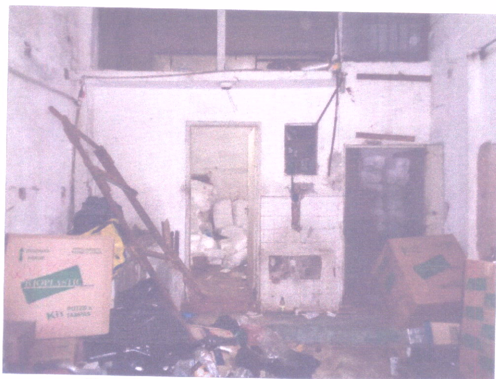
Figura 75 - Imóvel Avaliando (Térreo - 1º Pavimento).
