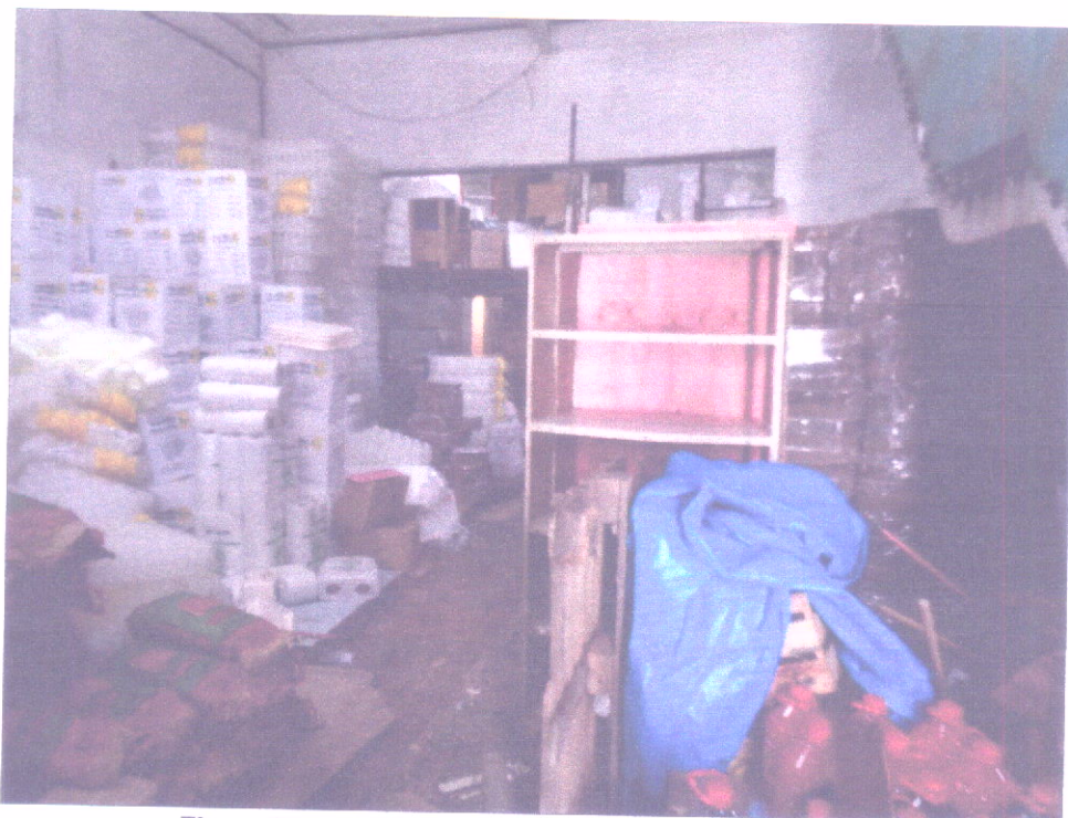
Figura 74 - Imóvel Avaliando (Térreo - 1º Pavimento).
