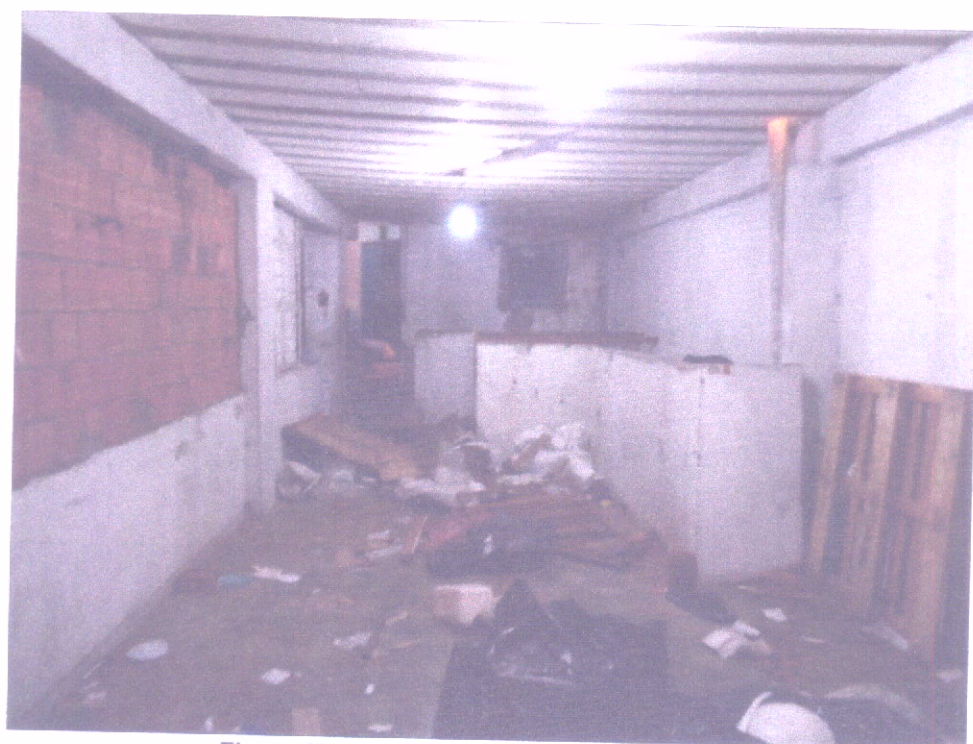
Figura 69 - Imóvel Avaliando (2º Pavimento).
