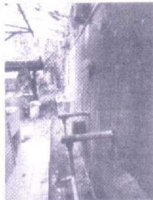
Foto 12 – Muro de contenção existente nos fundos do terreno
