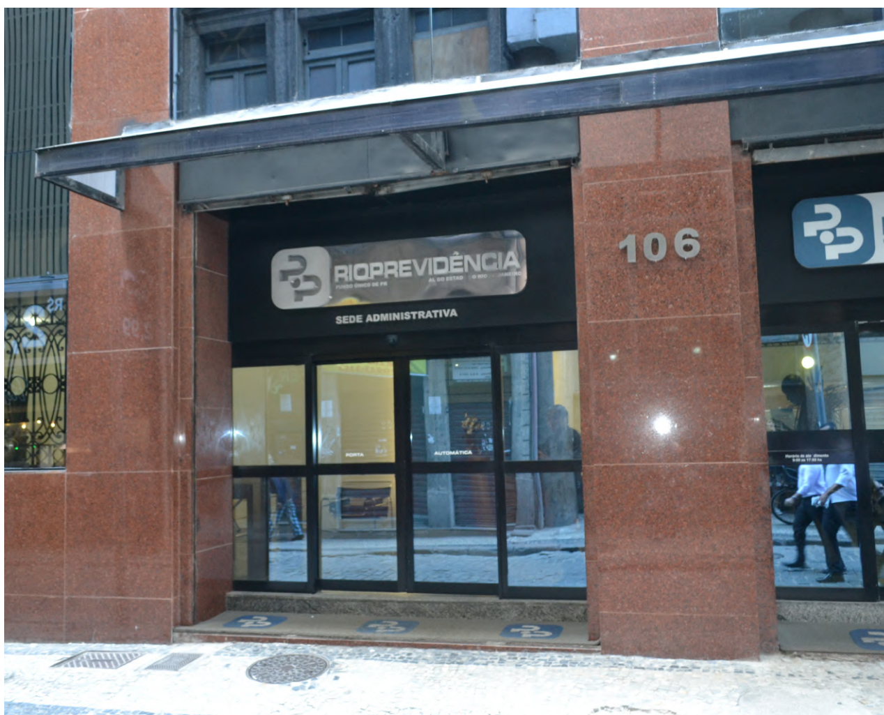
Sede administrativa do Rioprevidência, localizada na Rua da Quitanda, 106
